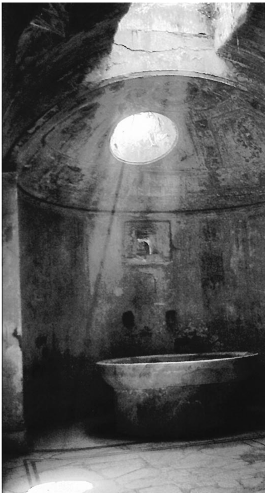
Figura 4.17: finestra circolare che illumina il labrum (vasca per le abluzioni) nel caldarium (ter- me di Pompei, architetto Vitruvio). Me- diante un lucernario rettangolare è possi- bile illuminare il resto del locale
