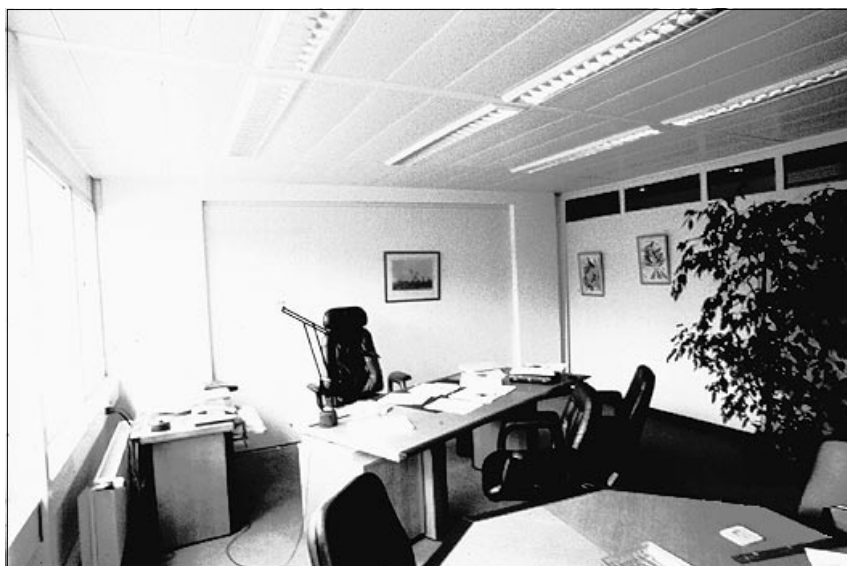
Figura 4.20: vista del nuovo impianto d'illuminazione
