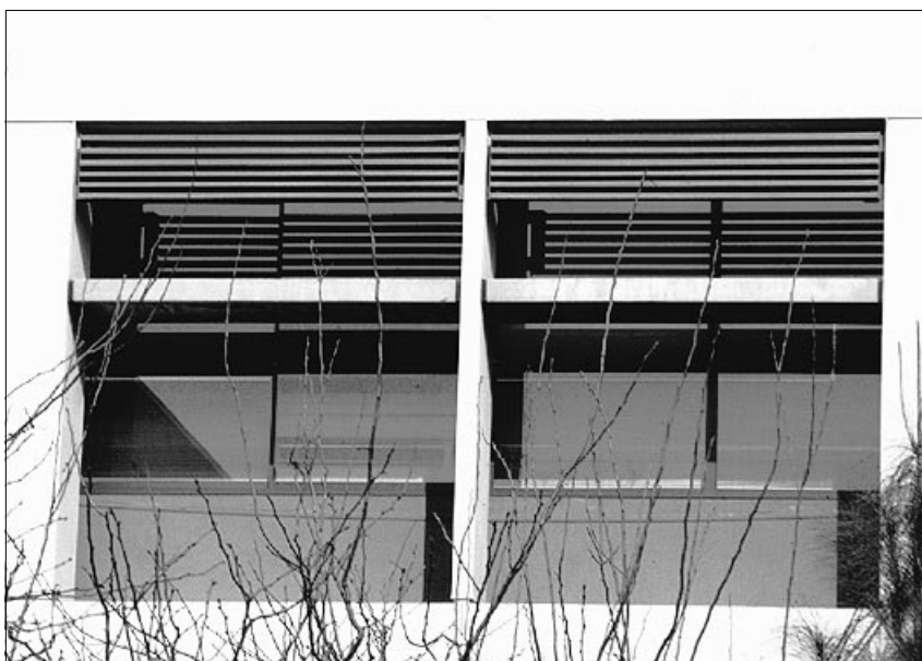
Figura 3.16: esempio di deflettore della luce (edificio dello Stato della California, Sacramento, USA)
