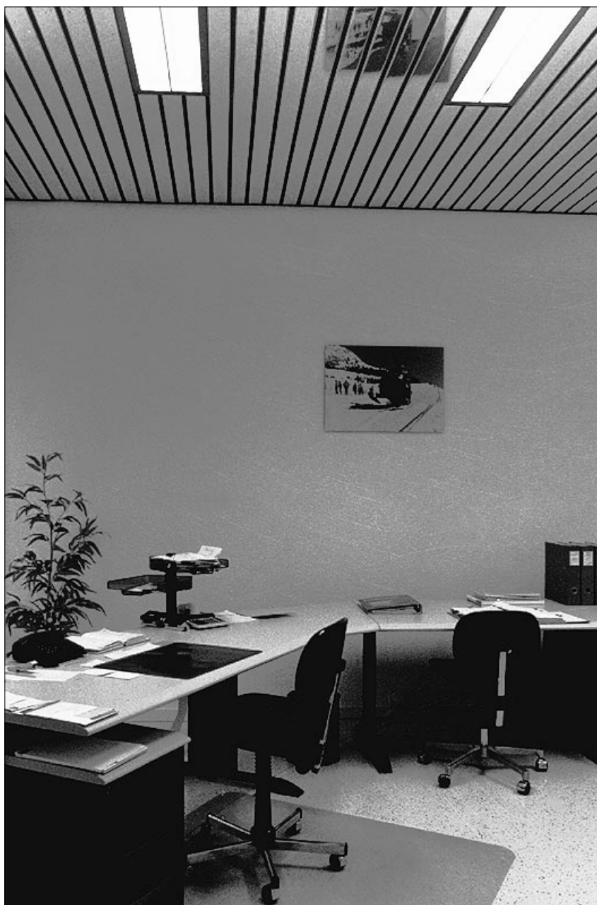
Figura 4.6: illuminazione diretta di un ufficio (corpi illuminanti a lamelle)
