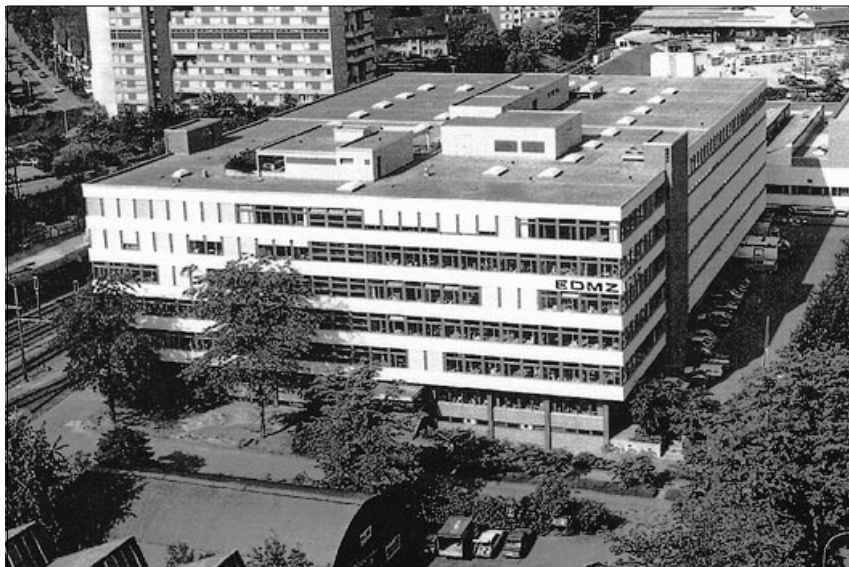
Figura 4.21: vista dell'edificio dell'UCFSM a Berna
