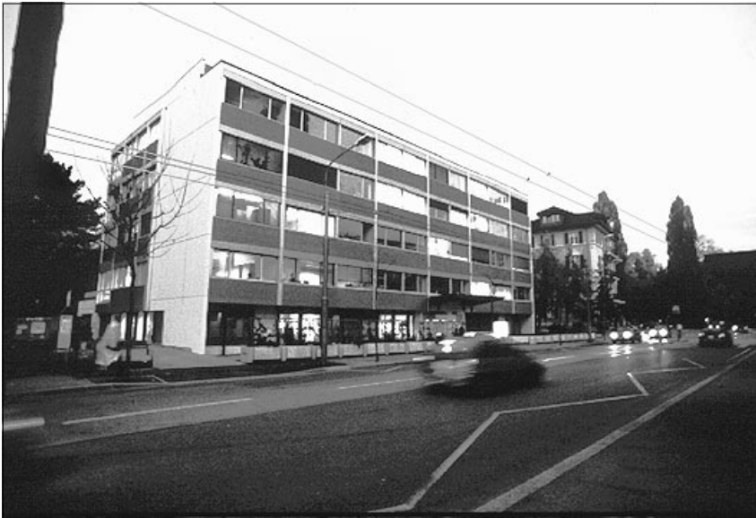
Figura 4.18: vista dell'edificio dell'UAP a Losanna
