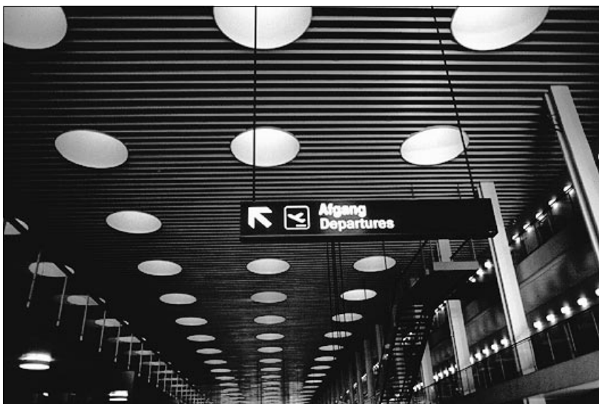
Figura 3.18: esempi di aperture zenitali (aeroporto di Copenaghen, Danimarca)
