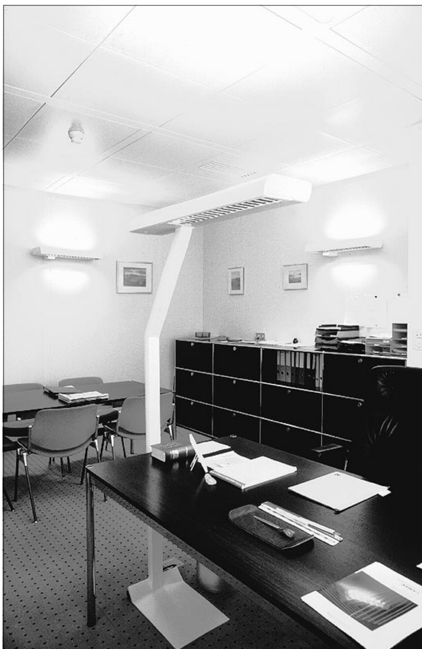
Figura 1.1: illuminazione diretta/indiretta mediante lampadari mobili e applique complementari in un locale adibito ad ufficio (gestione ed amministrazione)
