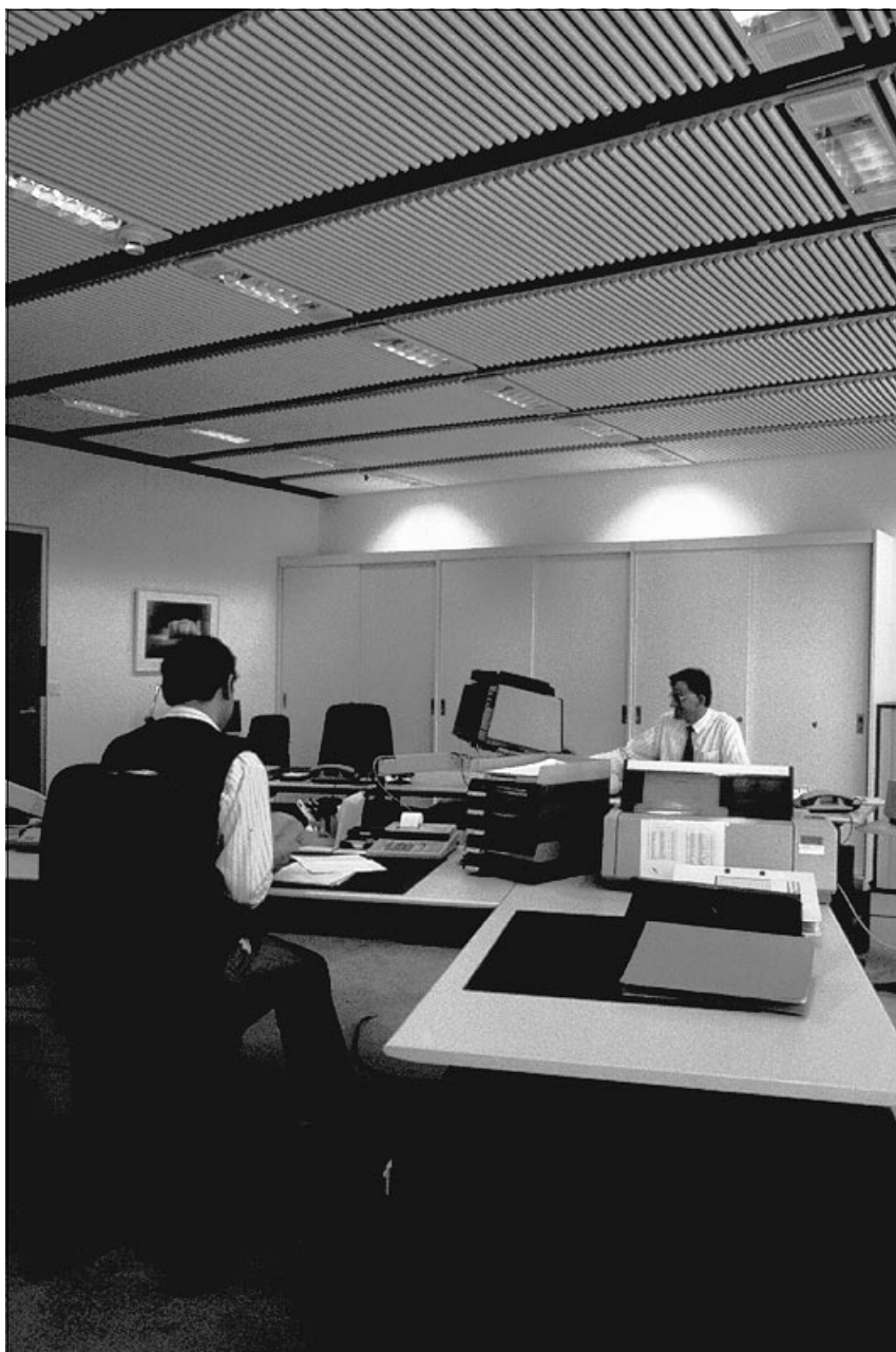
Figura 4.11: esempio di un'illuminazione diretta del tipo «darklight» (ufficio munito di schermi)
